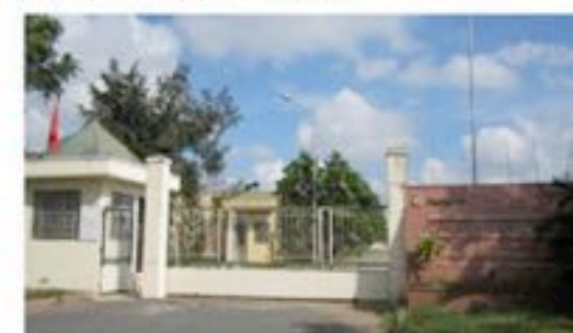
Nhà Máy Xử Lý Nước Thái KCN - Thanh Yên
